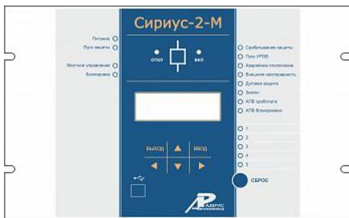
Микропроцессорное устройство защиты «Сириус-2-М» предназначено для выполнения функций релейной защиты, автоматики, управления и сигнализации присоединений напряжением 3–35 кВ. Устройство специализировано для применения в метрополитене.
